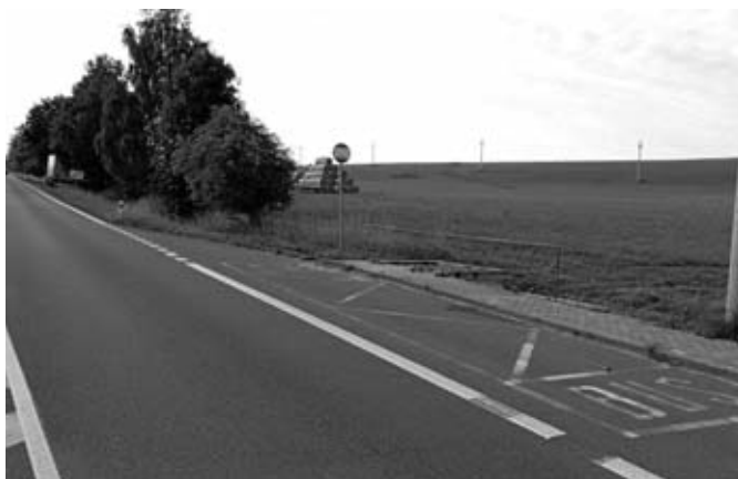
Příprava pro montáž přístřešku nové čekárny
